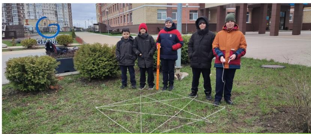
НАНЕСЕНИЕ РАЗМЕТКИ НА УЧАСТКЕ
